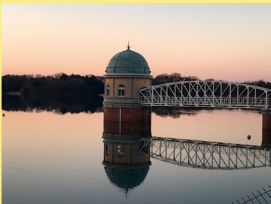
多摩湖の取水塔
