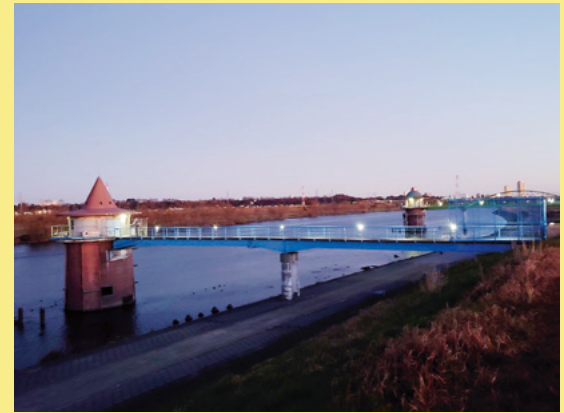
夕暮れの金町浄水場取水塔
