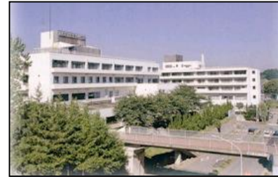
多摩永山病院 (東京都多摩市)
